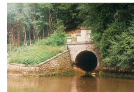
Výtokový portál levostranné obtokové štoly.
